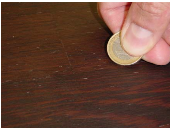
Abb. 1: Oberfläche vor Coin-Test
