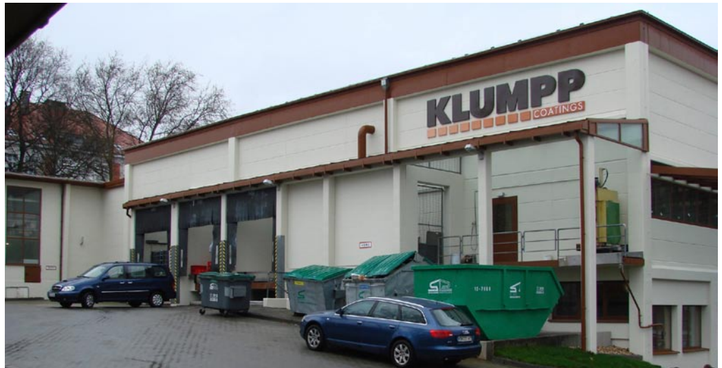
Das neue Klump-Werk in Wuppertal wurde innerhalb von drei Monaten produktionsbereit gemacht.
